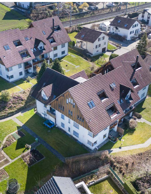
↑ Erwerb der neuen Siedlung Riedstrasse in Hedingen (Seite 24).
