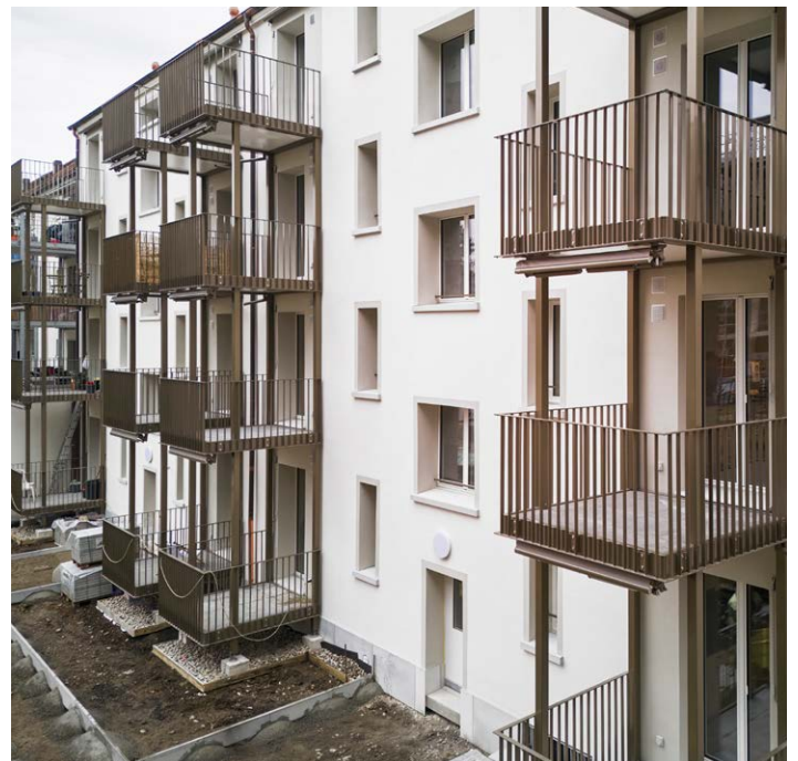
↑ Neue Balkone an der Hardstrasse 45 und 47.
