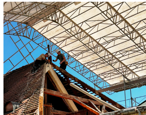
Das Schutzdach bewahrt den Dachstock der Liegenschaften Nussbaumstrasse 16 und 20 vor Regen und Witterungseinflüssen.
