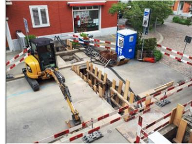
Die Liegenschaften der Siedlung Rotachquartier werden durch ein eigenes Fernwärmenetz von der Heizzentrale Birkenhof aus mit Wärme versorgt. Der unterirdisch verlegte Teil dieses Wärmenetzes kreuzt an einigen Stellen die Strassen des Rotachquartiers und ist mit gut 50 Jahren nun am Ende seiner Lebensdauer angekommen.
