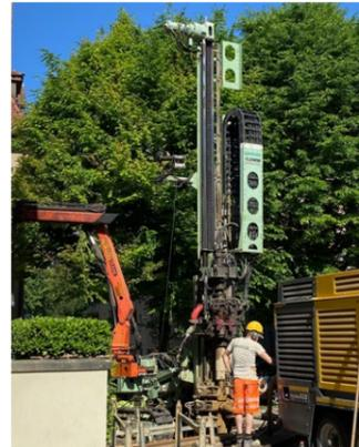
Für die Erdsonden wird bis zu 330 Meter tief gebohrt
