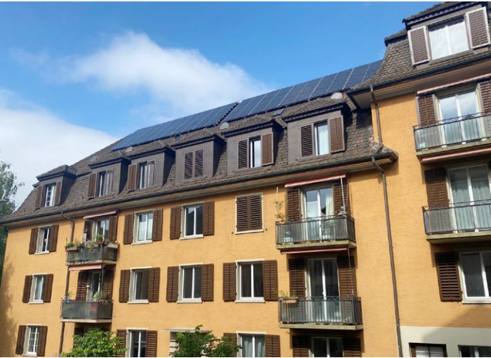
PV-Anlage auf dem Dach der Siedlung Hammer/Fröbel
