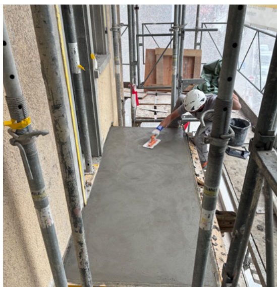
Die Balkonplatten werden vor Ort neu gegossen.
