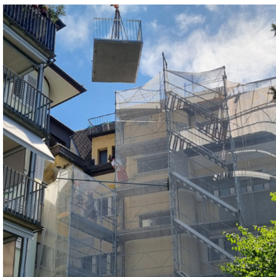
Die hofseitigen Balkontürme werden montiert.
