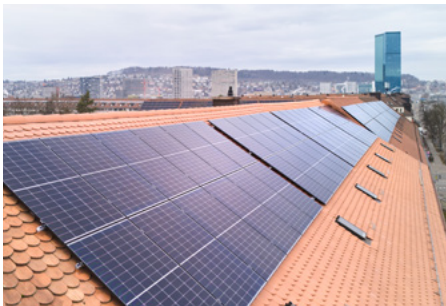
Auch die Häuser an der Hardstrasse 45 und 47 wurden als Teil der Siedlung Hard West mit einer Photovoltaikanlage ausgerüstet.
