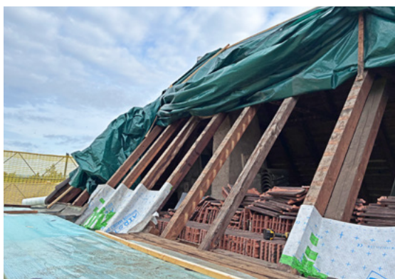
Dämmung der Dachkonstruktion.
