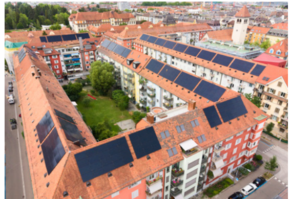
Ein Teil der installierten PV-Anlage im Rotachquartier aus der Vogelperspektive.
