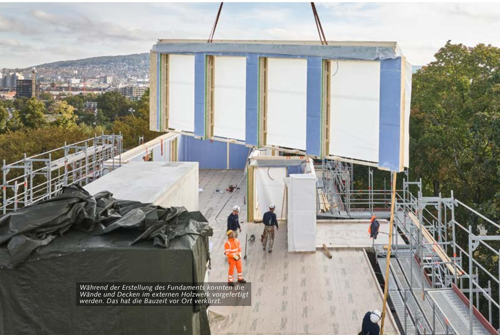
*Während der Erstellung des Fundaments konnten die Wände und Decken im externen Holzwerk vorgefertigt werden. Das hat die Bauzeit vor Ort verkürzt.*
