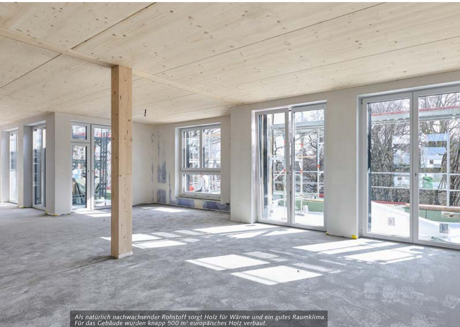
Als natürlich nachwachsender Rohstoff sorgt Holz für Wärme und ein gutes Raumklima. Für das Gebäude wurden knapp 500 m<sup>3</sup> europäisches Holz verbaut.
