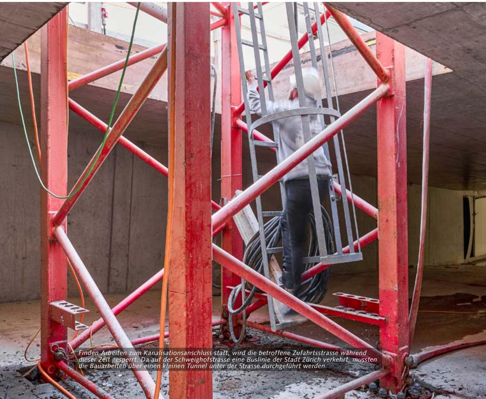
*Finden Arbeiten zum Kanalisationsanschluss statt, wird die betroffene Zufahrtsstrasse während dieser Zeit gesperrt. Da auf der Schweighofstrasse eine Buslinie der Stadt Zürich verkehrt, mussten die Bauarbeiten über einen kleinen Tunnel unter der Strasse durchgeführt werden.*
