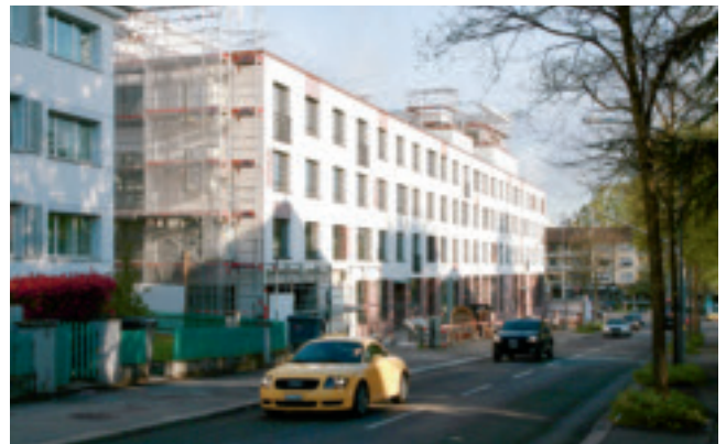
Strassenfassade an der Schweighofstrasse Text und Fotos: Christian Stelzer, Leiter Bau
