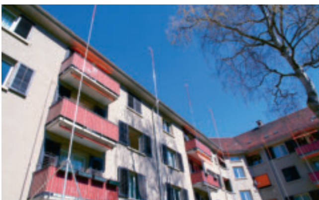
Aussteckung der neuen Balkone
