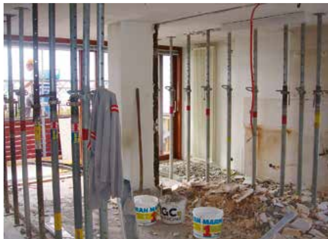
Der Wohnbereich während der Sanierung
