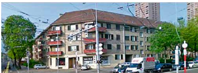
Hard West: Gesamtanierung ab 2017
