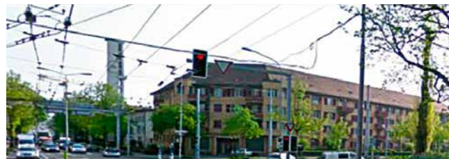
Hard Ost: Ersatzneubau ab 2019/2020
