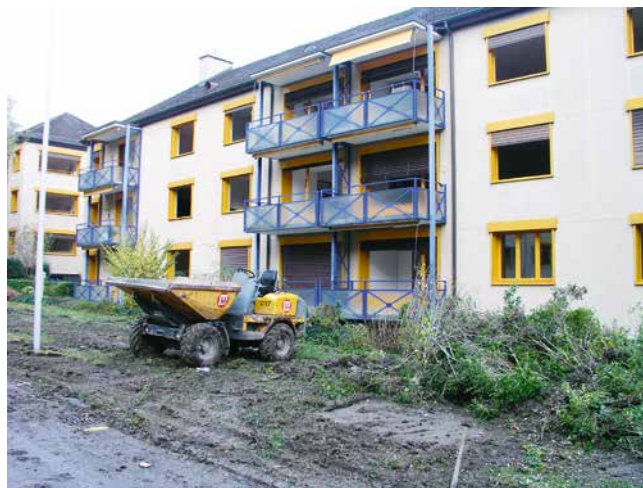
Der Rückbau hat bereits begonnen
