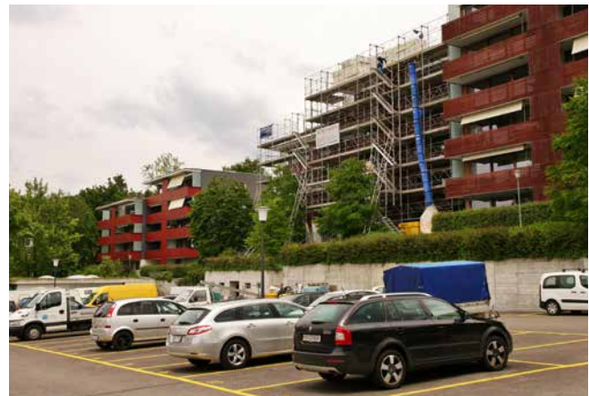
Blick über die sanierte Garage an die obere Hauszeile
