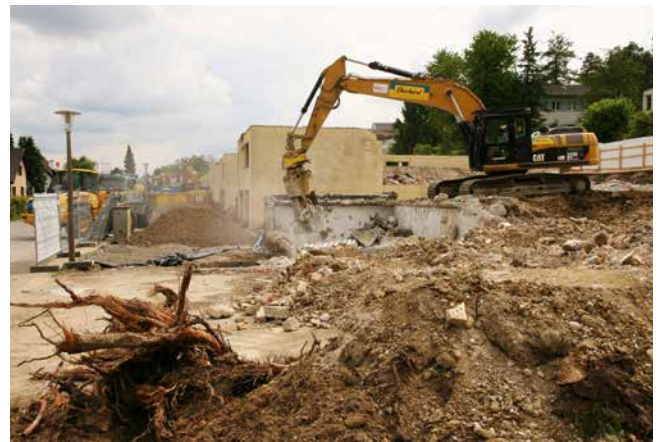
Abbruch der alten Häuser
