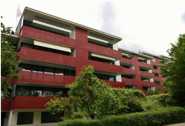
Die fertig sanierten Häuser Kirchgasse 7 - 11
