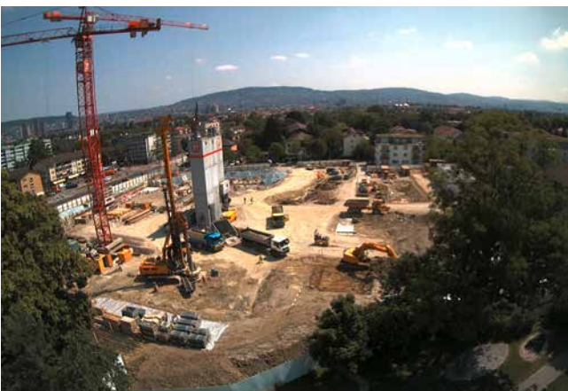
Blick von der Paul Clairmont-Strasse auf unsere Baustelle
