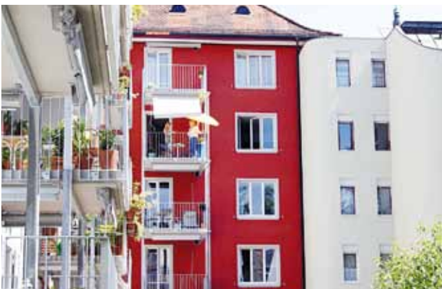
Die neuen Balkone werden bereits rege genutzt
